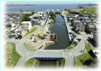
河川堤防整備
