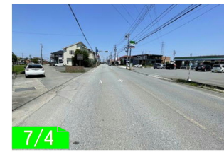
7/4 R166ライン剥離調査(田村町)
