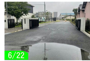
6/22 路面排水調査(鎌田町)
