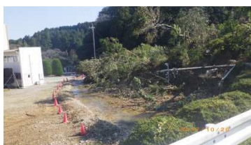
10/26 台風被害調査 嬉野町薬王寺
