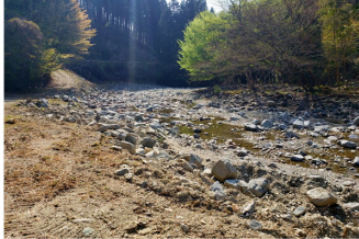
4/22堆積土砂の調査 飯南町下仁柿地内
