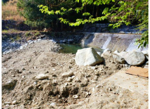
4/22農業用水路の調査 飯高町月出地内
