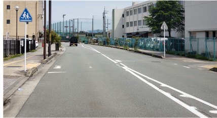
5/16横断歩道の調査 殿町地内（幸小学校横）
