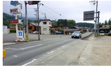
4/23国道166号線歩道の調査 飯南町粥見地内
