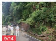
9/14 嬉野美杉線の法面調査 (嬉野ヶ野町地内)
