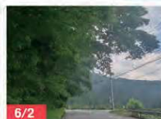
6/2 国道166号線・送電線に架かる樹木調査 (飯高町富永地内)
